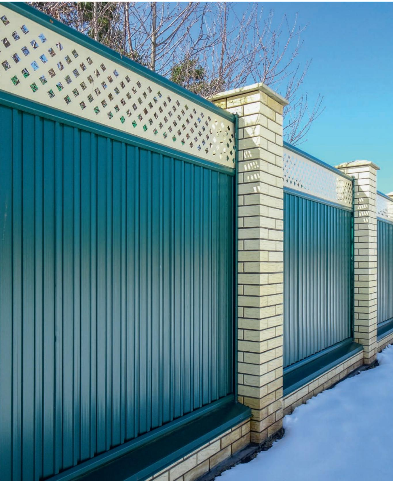
**Совет:** Ограждения со сплошным заполнением испытывают значительные ветровые нагрузки. Поэтому при комплектации ограждения необходимо учитывать ветровой район установки ограждения.
