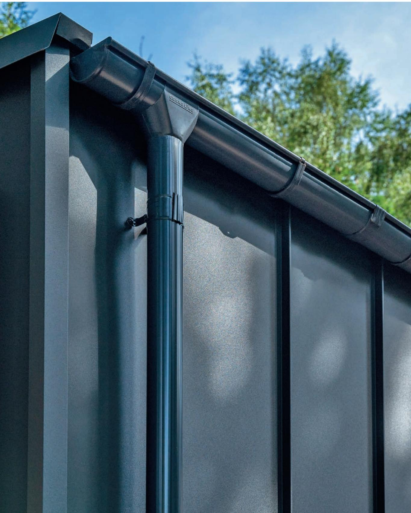
**Совет:** Металлические водосточные трубы монтируются обжимом вниз, иначе не избежать протечек! Для повышения герметичности желоба рекомендуем использовать кровельный герметик Grand Line®.
